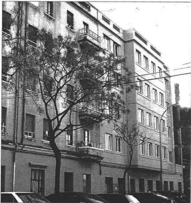
Edificio de la calle Pío XI de Valencia que ha sido rehabilitado para personas mayores de 65 años. LP
