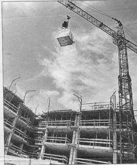
Una grúa durante las obras de construcción de unas viviendas. / EL MUNDO
